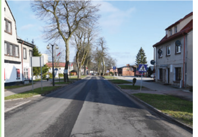
Ulica Sikorskiego po zakończonej modernizacji.
