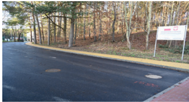
Ulica Leśna po modernizacji.
