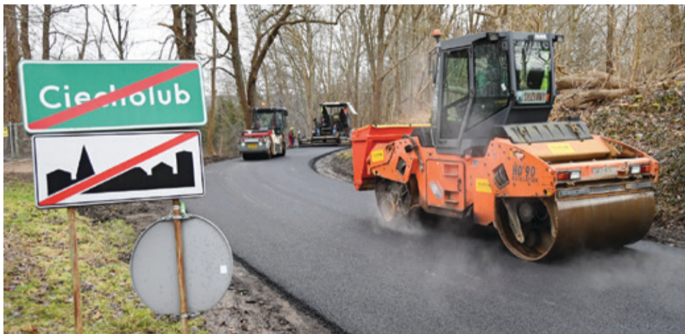
W trakcie prac na odcinku Ciechołub – Darnowo.
