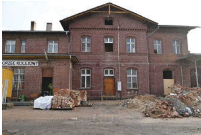
Na dworcu PKP trwają intensywne prace budowlane.
