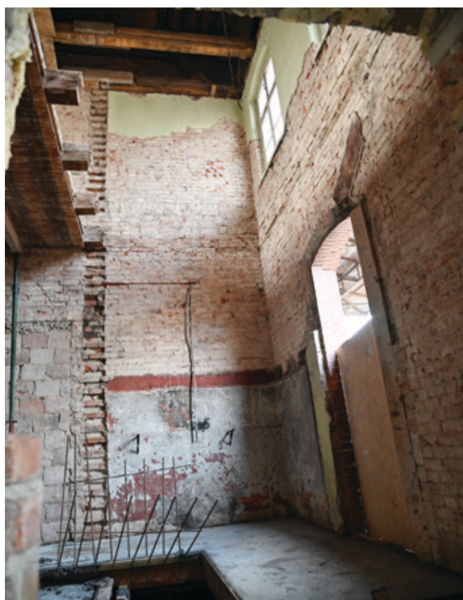
Obecnie prowadzone są konieczne prace rozbiórkowe wewnątrz budynku.
