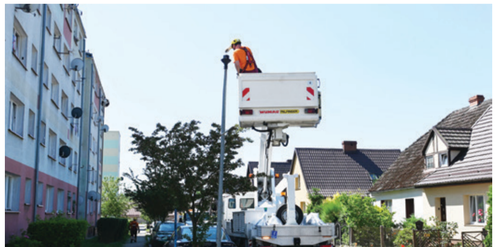
Wymiana opraw w Kępicach prowadzonych na zlecenie spółki Energa latem 2023 r.
