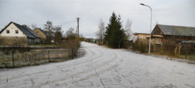
Zdjęcia przed i po zakończonej modernizacji drogi w Mzdowcu.
